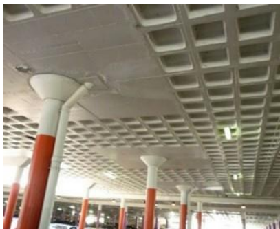
Dalle nervurée (Fig. 7)
